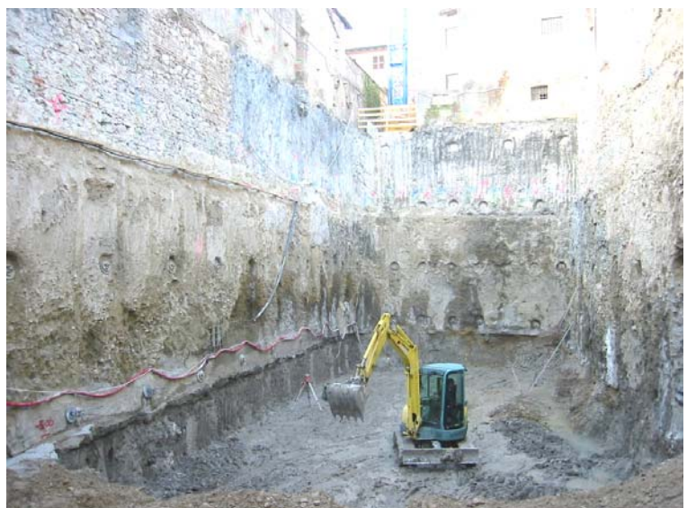
▲ Vista del cantiere dopo lo scavo
