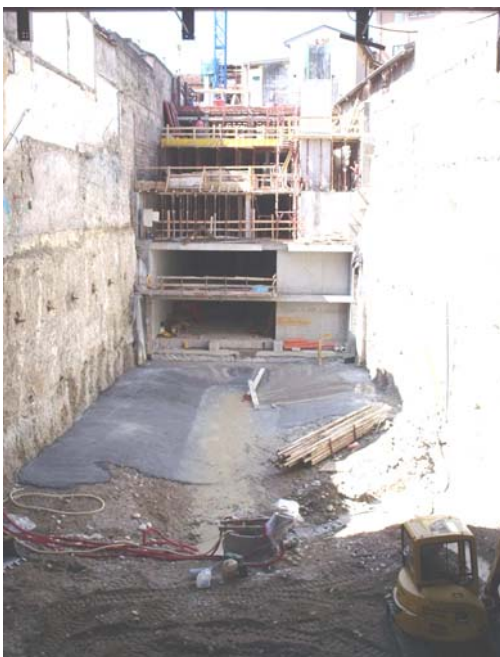
▲ Realizzazione della struttura in cemento armato
