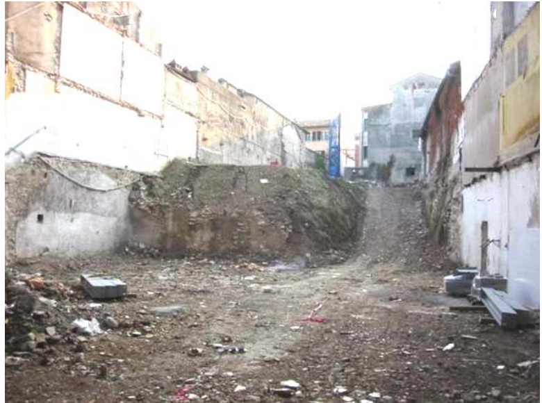
▲ Stato iniziale dell' opera
