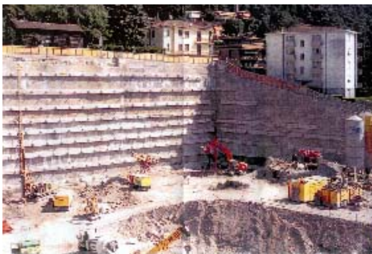
▲ Panoramica Ovest del cantiere
