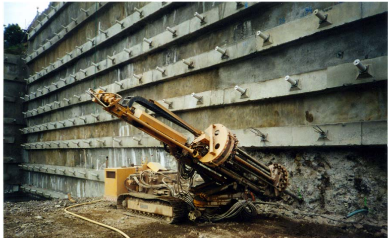
▲ Fase di esecuzione tiranti
