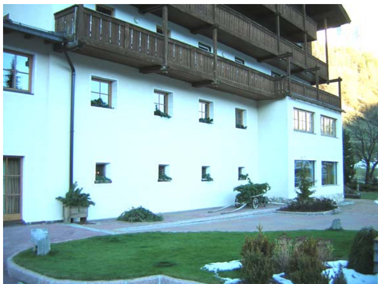
▲ Situazione prima dell'intervento Keller
