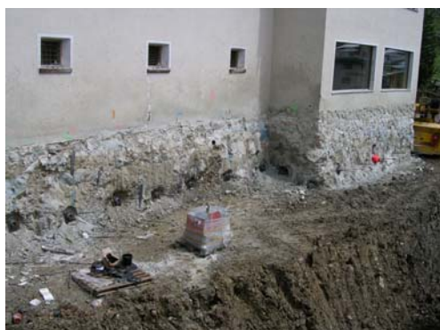
▲ Parete Soilcrete Jet-Grouting in sottofondazione durante la fase di scavo
