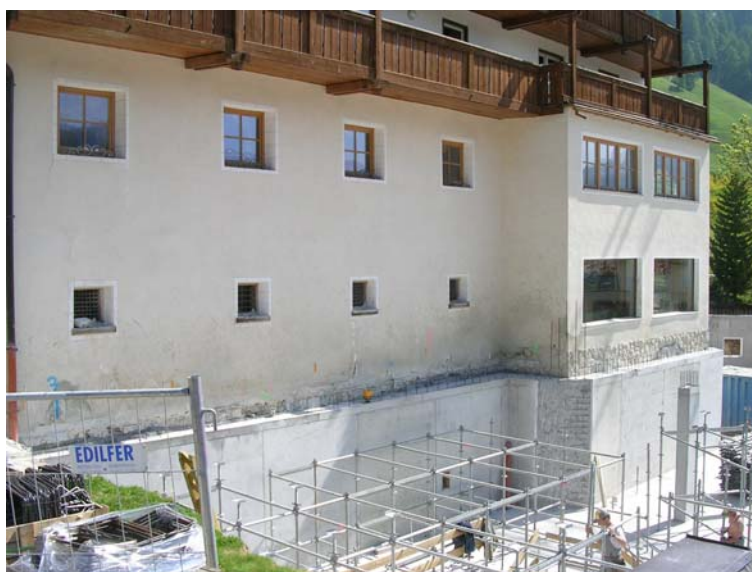
▲ Fase di getto della parete finale a filo del fabbricato esistente e direttamente contro l'opera provvisoria SOILCRETE Jet-Grouting
