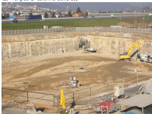
▲ Panoramica di cantiere
