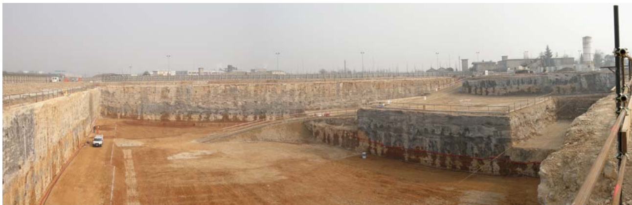
▲ Panoramica di cantiere a termine degli scavi
