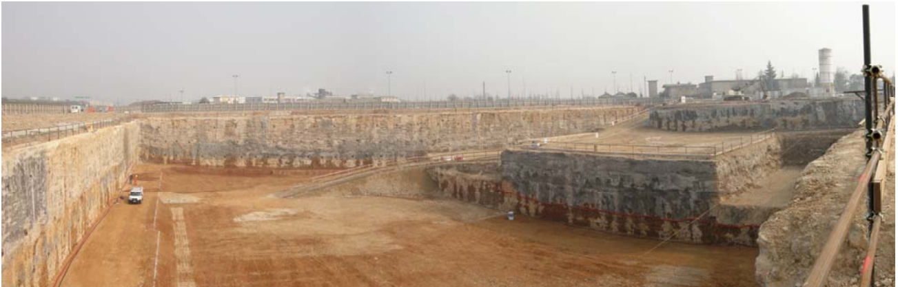
▲ Panoramica di cantiere a termine degli scavi
