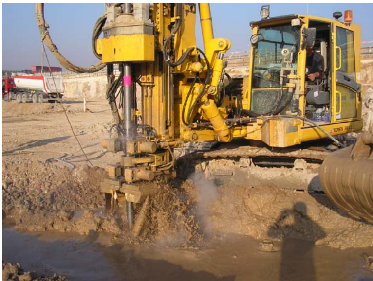
▲ Esecuzione colonne Soilcrete Jet-Grouting
