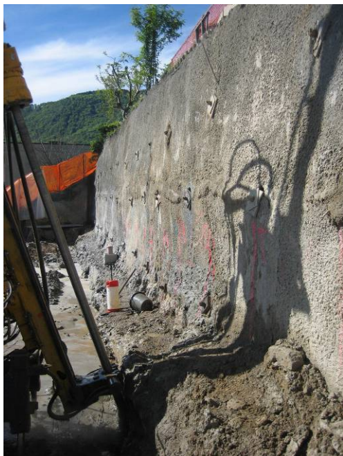
▲ Esecuzione colonne Soilcrete Jet-Grouting
