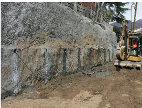
▲ 1° Fase: chiodatura parete Spritz-beton alla sommità della paratia
