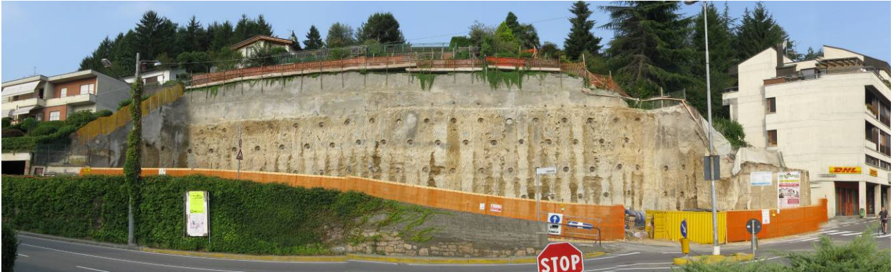
▲ Panoramica di cantiere a termine degli scavi
