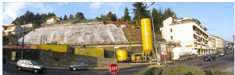
▲ Situazione ad inizio cantiere
