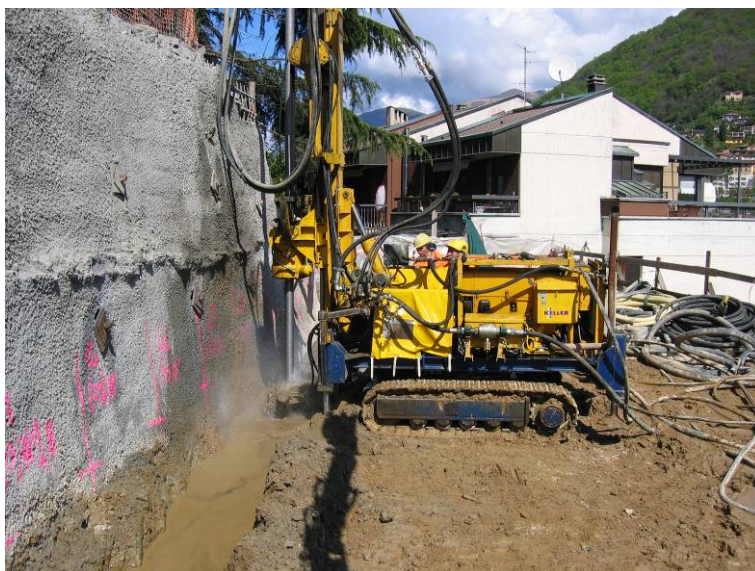
▲ Esecuzione colonne Soilcrete Jet-Grouting
