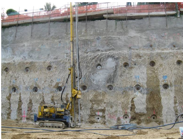
▲ Panoramica della paratia nel corso dei lavori
