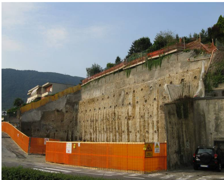
▲ Panoramica di cantiere a termine degli scavi
