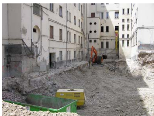
▲ Fase di scavo
