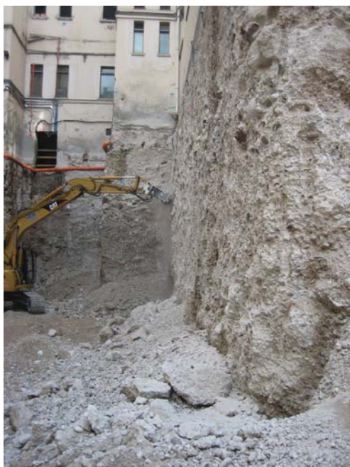
▲ Fase di riprofilatura della parete Soilcrete
