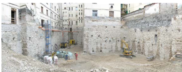
▲ Panoramica di cantiere
