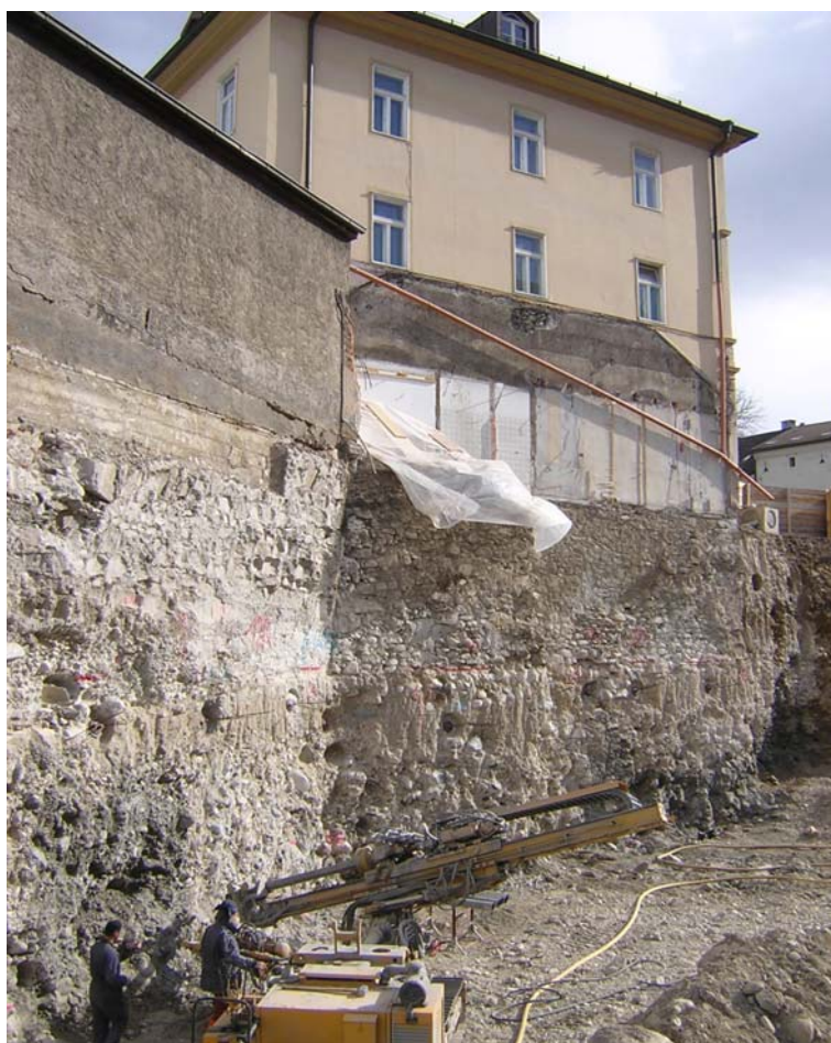
▲ Sottofondazione Casa Leitner : fase di esecuzione tiranti provvisionali
