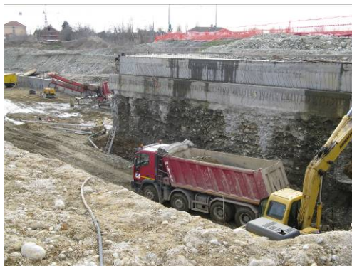
▲ Fase di scavo
