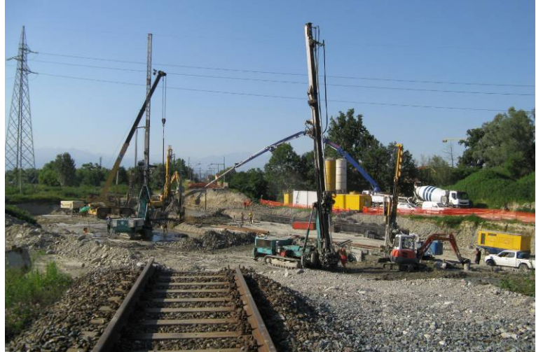
▲ Interruzione linea ferroviaria ed inizio attività di cantiere
