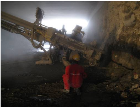
▲ Fase di tirantatura nel tratto "scatolare"
