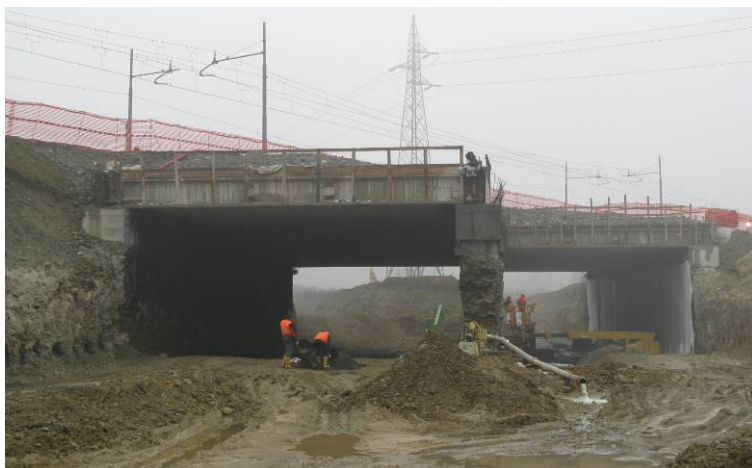
▲ Ultimazione dei lavori di scavo
