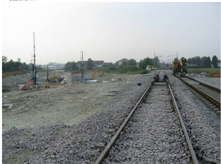
▲ Ripristino della linea ferroviaria
