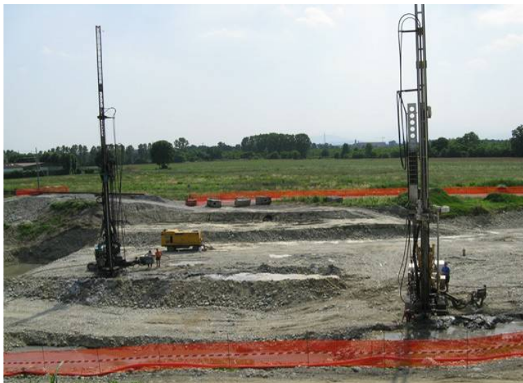
▲ Panoramica di cantiere
