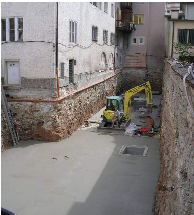
▲ Vista del cantiere dopo lo scavo
