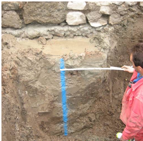
▲ Corpo consolidato Soilcrete Jet-Grouting in sottofondazione di un edificio esistente
