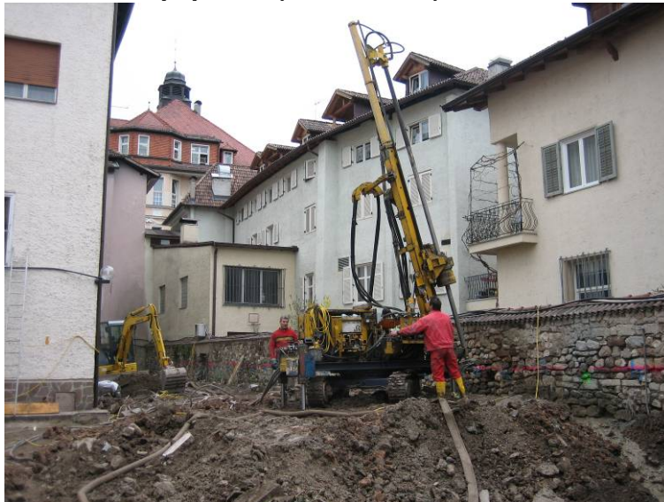
▲ Fase di esecuzione Soilcrete Jet-Grouting
