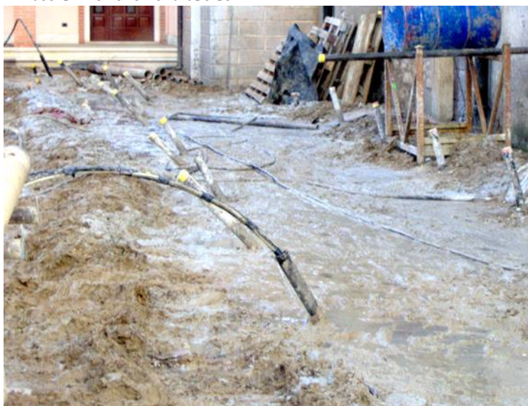
▲ Fase di iniezione zona canonica
