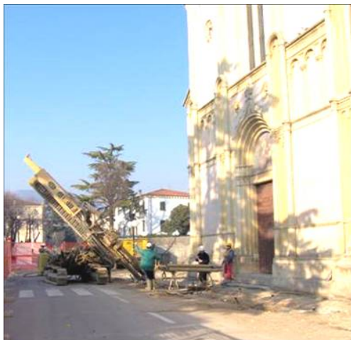
▲ Fase di perforazione
