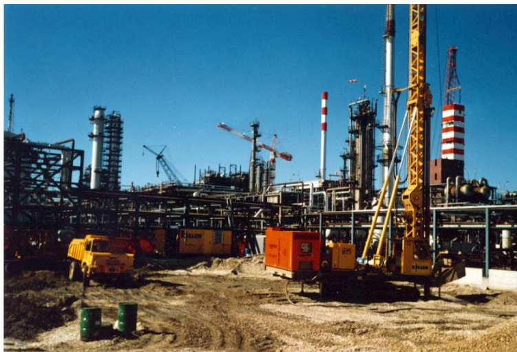
▲ Esecuzione di Colonne in Ghiaia Vibrocompattate
