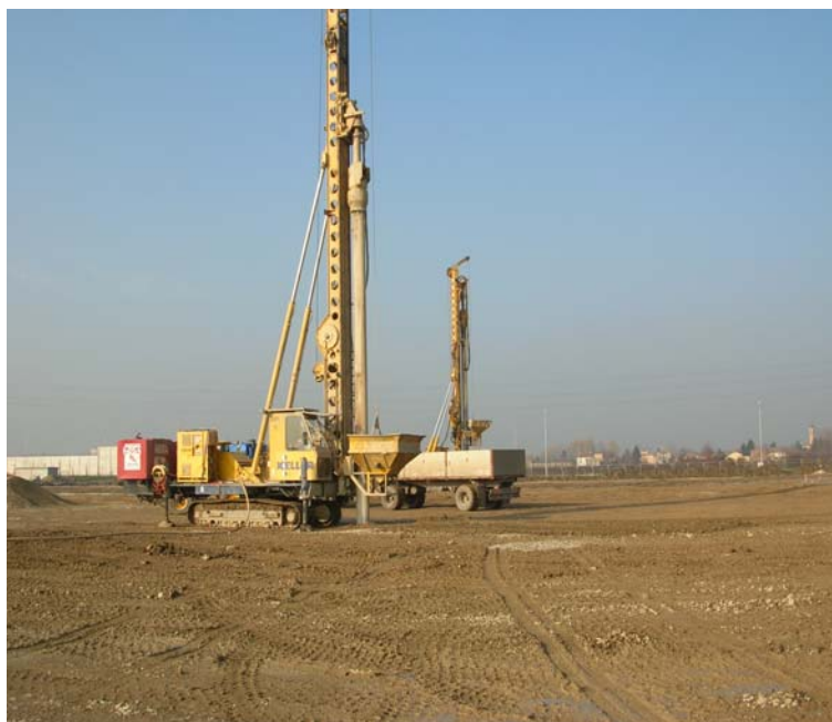
▲ Esecuzione colonne CGV con la tecnica "Bottom Feed"
