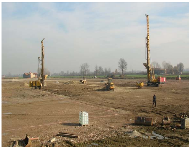
▲ Panoramica del cantiere durante l'intervento
