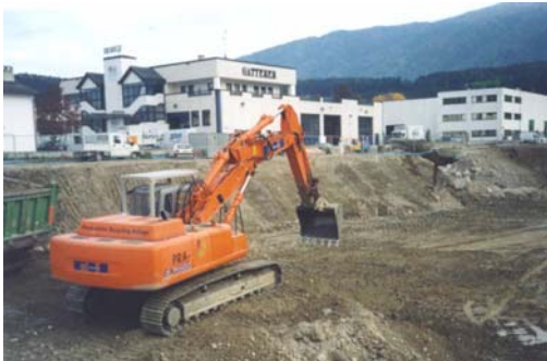
▲ Vista generale dell'area ad inizio lavori
