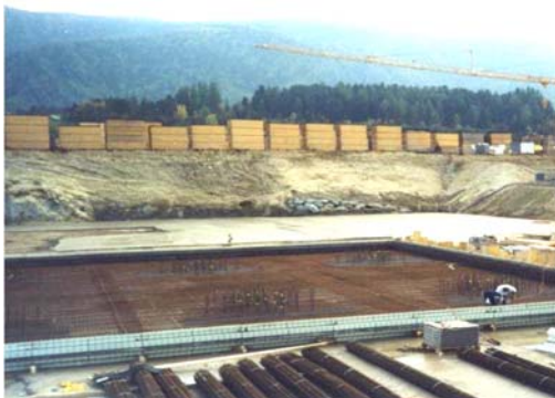
▲ Costruzione della platea di fondazione
