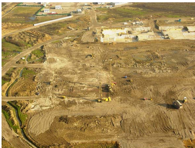
▲ Foto aerea del cantiere
