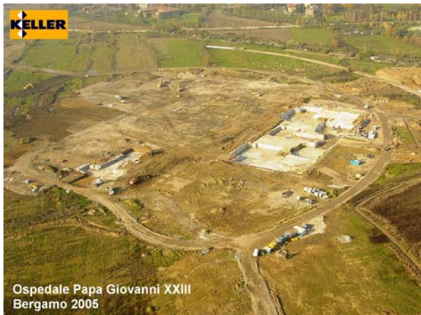
▲ Foto aerea del cantiere
