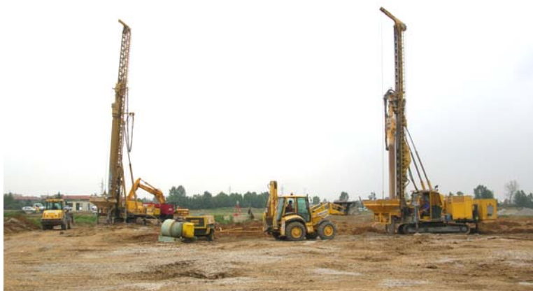
▲ Torri guida Keller durante l' esecuzione delle colonne CGV
