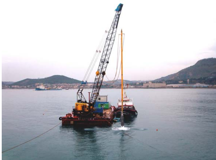
▲ Esecuzione vibroflottazione
