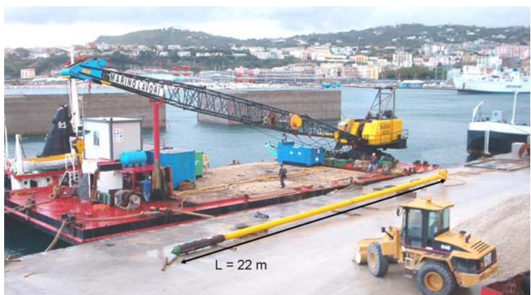
▲ Fasi di montaggio e preparazione dell' attrezzatura vibro
