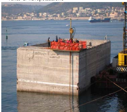
▲ Esecuzione prove penetrometriche di controllo direttamente da cassone
