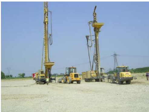
▲ Esecuzione colonne CGV parzialmente cementate con 2 Torri da Keller
