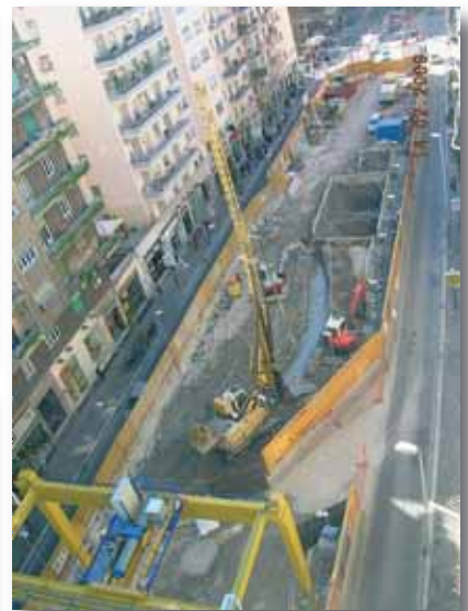
Il cantiere in esame. Sulla sinistra il fabbricato 85, le cui strutture di fondazione erano state interessate da fenomeni deformativi
