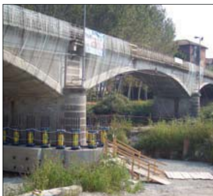
Panoramica del ponte al termine del sollevamento
