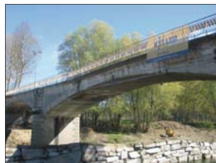
Scogliera provvisoria propedeutica ai lavori
