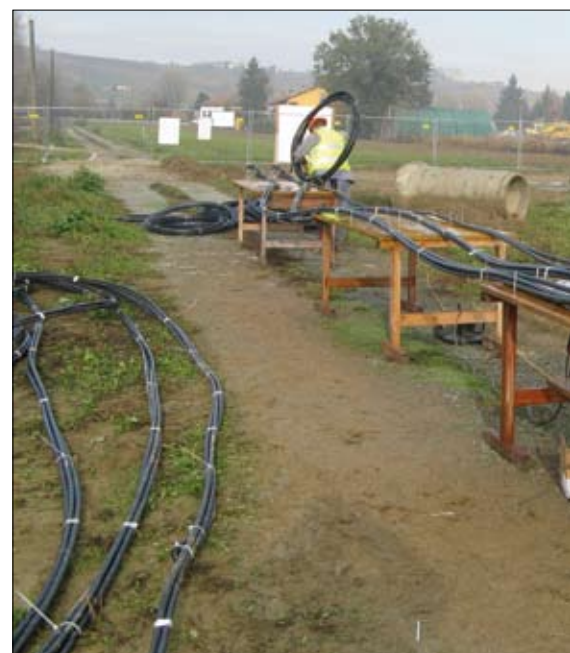
Fig. 7. Preparazione sonde geotermiche
