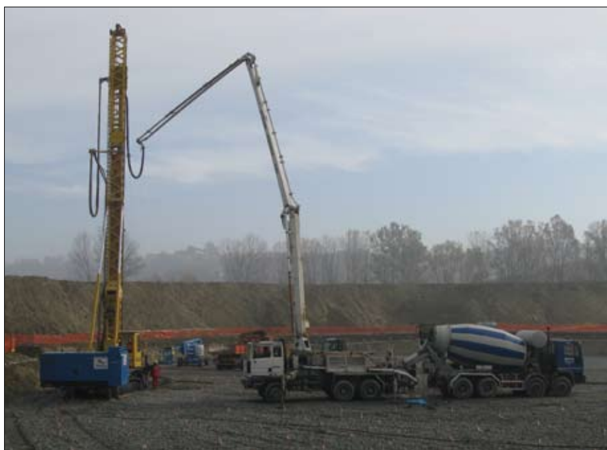
Fig. 5. Panoramica di cantiere
