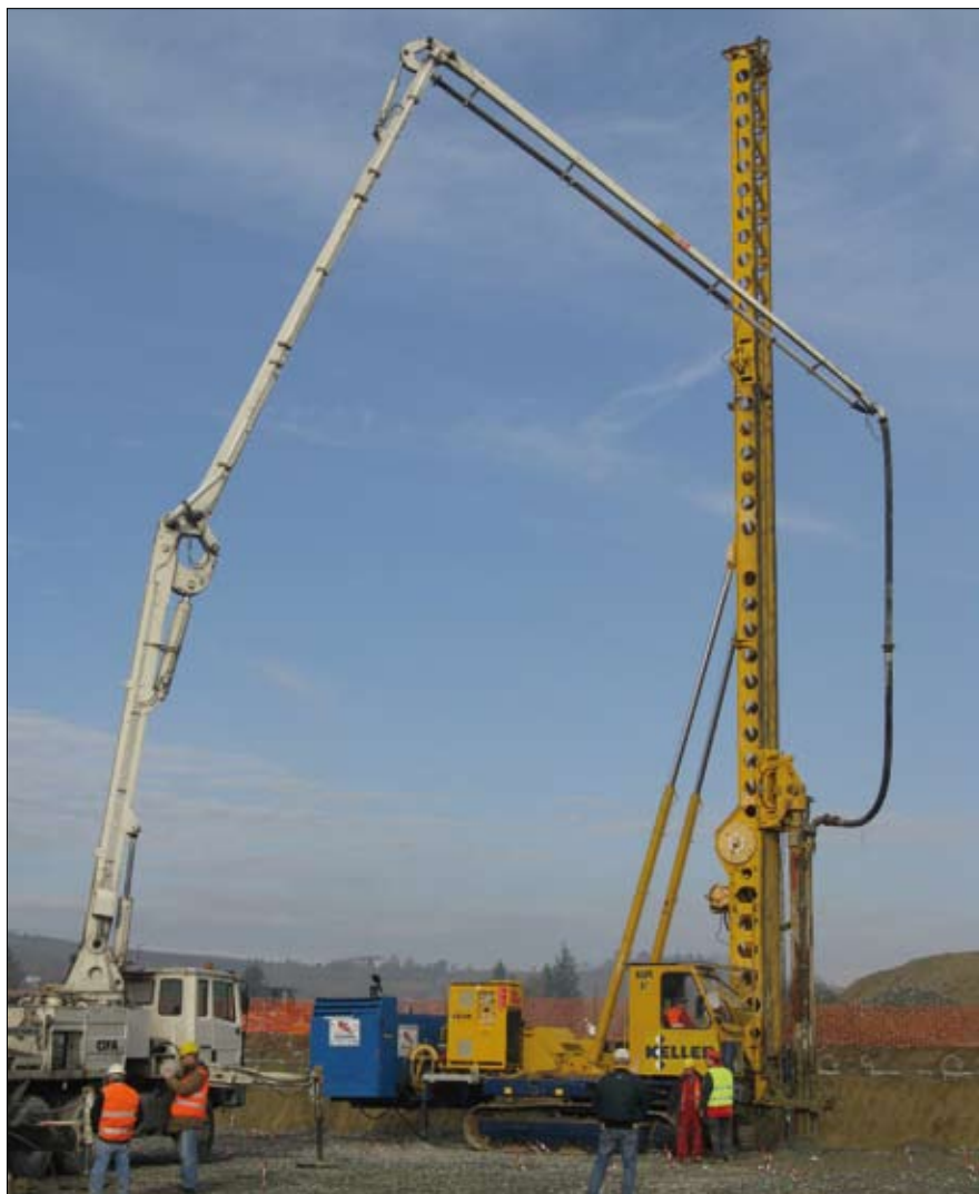
Fig. 4. Esecuzione colonne CVC
