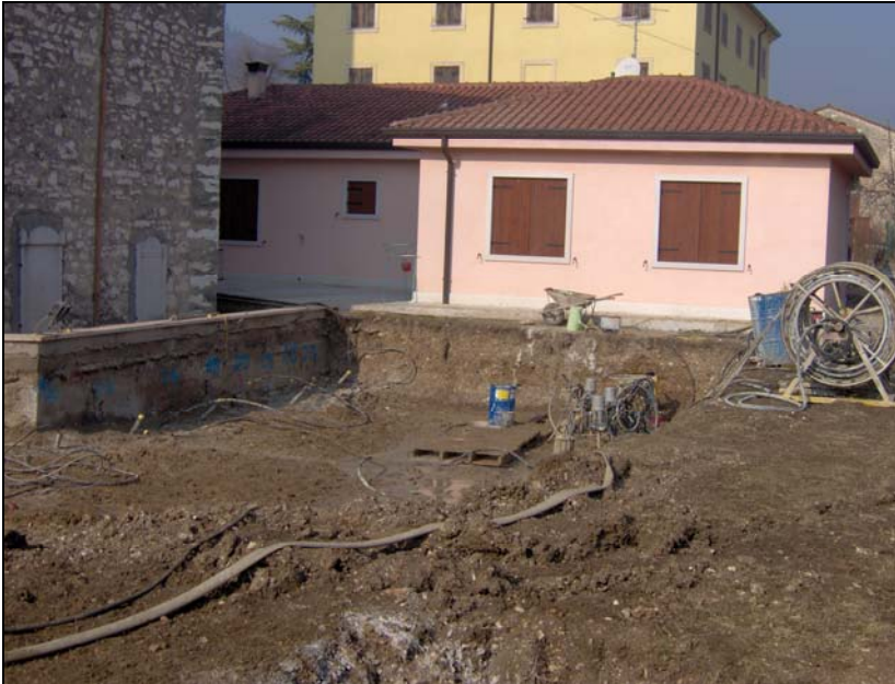
Iniezioni SOILFRAC , nel settore dell'abside della struttura.
