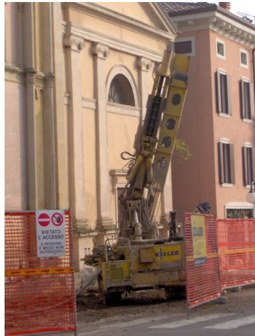
Perforazioni tipo "a" (lato strada).
