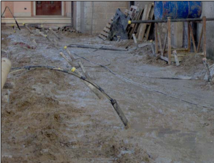
Iniezioni SOILFRAC , nel settore della canonica
