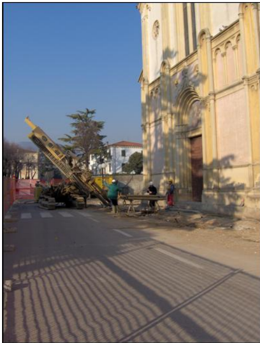
Perforazioni tipo "d" (lato strada).
