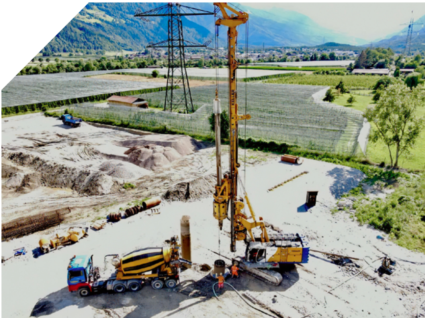
HERSTELLUNG DER PFÄHLE IM SÜDLICHEN BAUFELD
