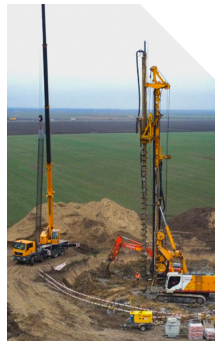
HERSTELLUNG DER SOB-PFÄHLE mit der BG36
